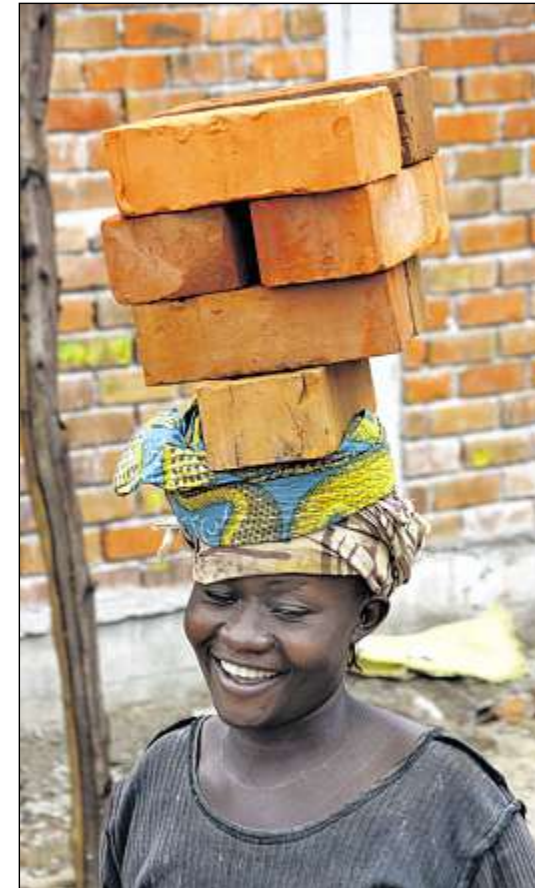
BEIM BAU EINER SCHULE der Hilfsorganisation sind nicht Maschinen, sondern Kopfarbeit üblich.
